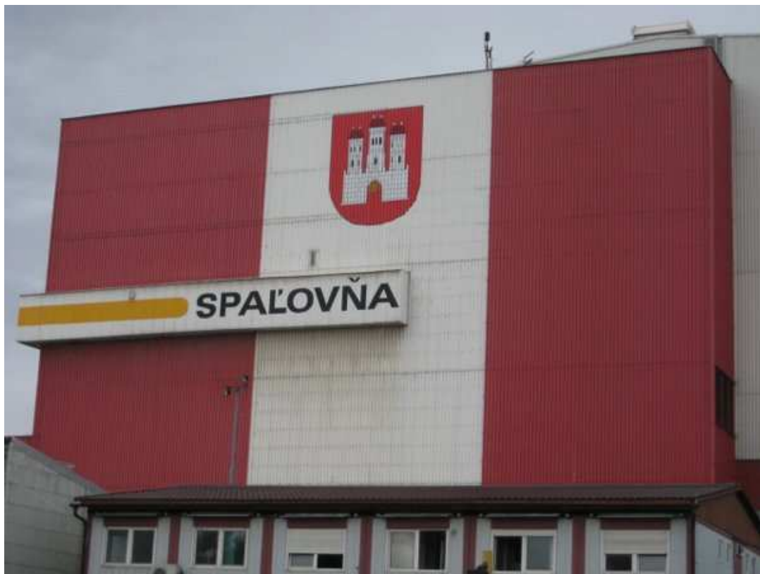
Súčasný pohľad na východnú fasádu s nápisom SPALOVŇA
