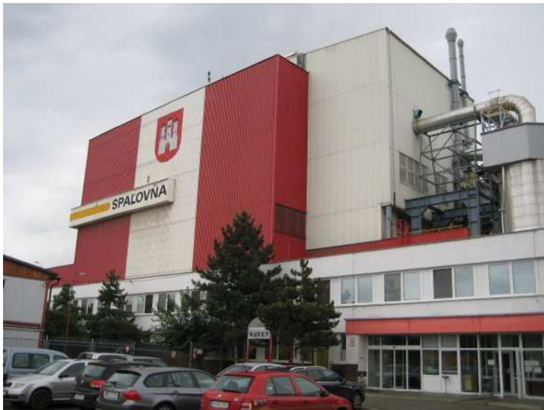
Súčasný pohľad na východnú a časť severnej fasády
